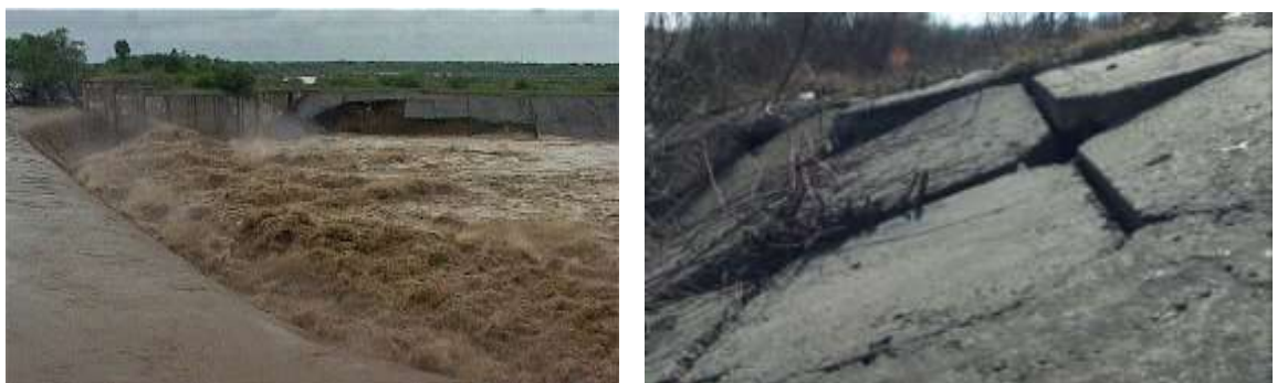
Рис.2 – Річка Бистриця Надвірнянська під час повені та руйнування дамби
